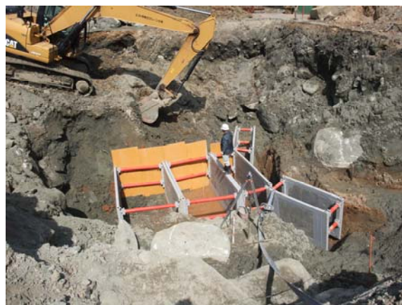
図-7 施工状況写真
