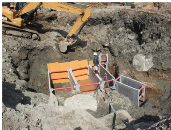
図-7 施工状況写真
