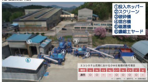
処理設備外観
