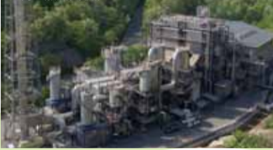
金属・蒸気回収炉
