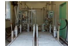
危険物取扱施設
